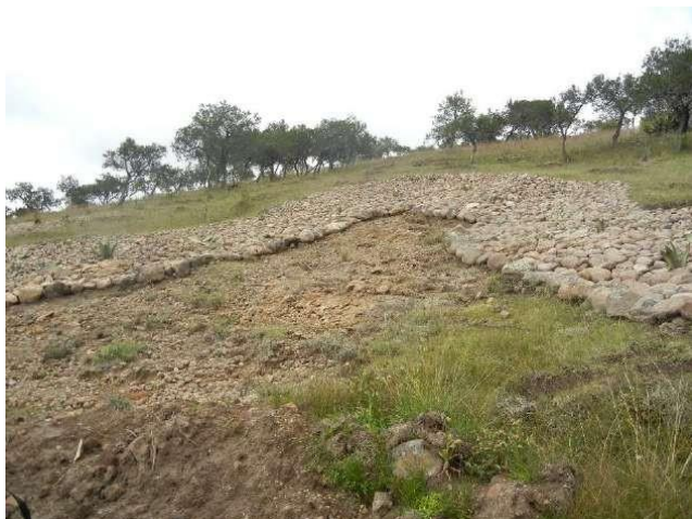
Figura 11. Cabeceo de cárcavas, caso 2. Fuente: Elaboración propia.
