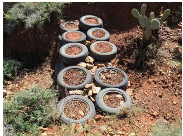
Figura 13. Presa de llantas, caso 3. Fuente: CONAFOR, 2015.
