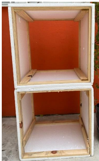
Figura 5. Estructura de los módulos. Placas de poliestireno expandido con estructura de madera.
