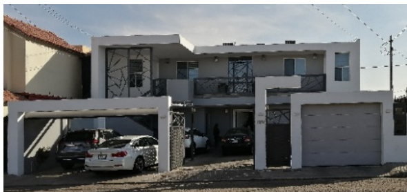
Figura 1. Fachada principal edificio estudio.
