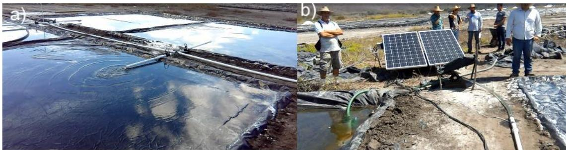
Figura 8. a) Implementación de sistema de tuberías de alimentación a las eras y estanques, b) Sistema Fotovoltaico Aislado.
