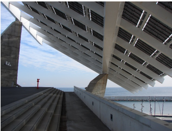
Figura 6. Vista de las gradas bajo la pérgola fotovoltaica. Fuente: archivo del autor.
