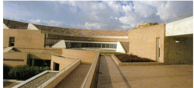
Figura 14. Cubierta recorrible biblioteca Virgilio Barco. Téllez, 2006, p. 596.
