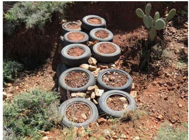
Figura 13. Presa de llantas, caso 3. Fuente: CONAFOR, 2015.
