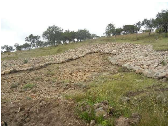
Figura 11. Cabeceo de cárcavas, caso 2. Fuente: Elaboración propia.
