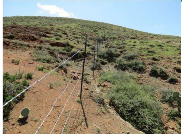
Figura 12. Cercado de poste de fierro con alambre de púas. Fuente: CONAFOR, 2018.
